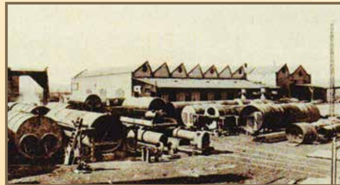
Rustonka – pohľad na parné kotly
