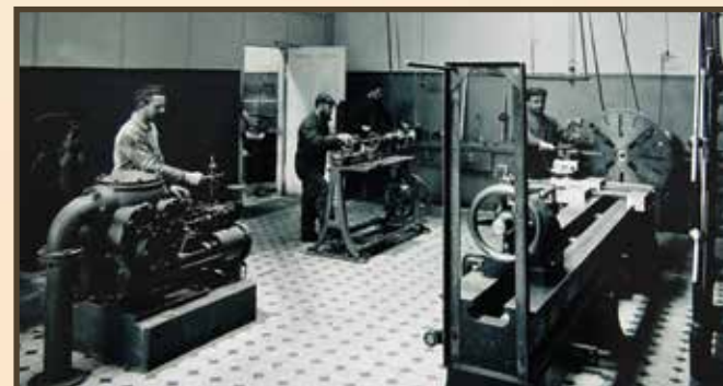
Merania na parných strojoch v laboratóriu
